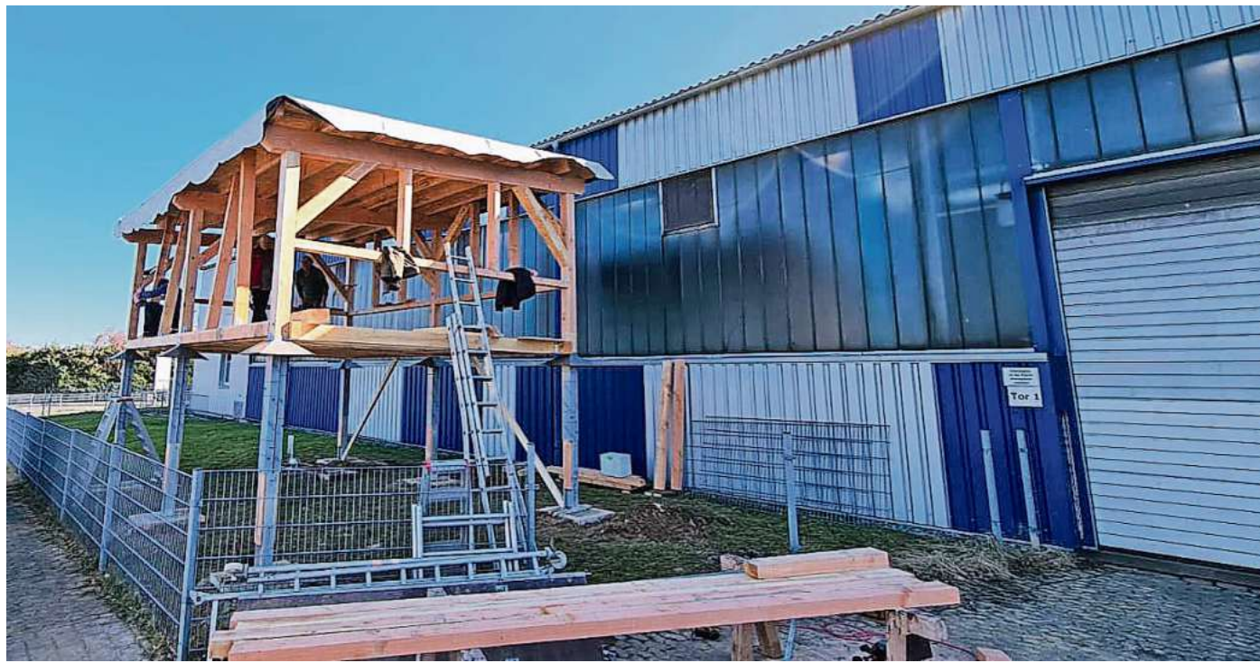
Auf dem Gelände der Andreas Wasserfuhr GmbH entsteht ein Bruthaus für Rauchschnalben.
